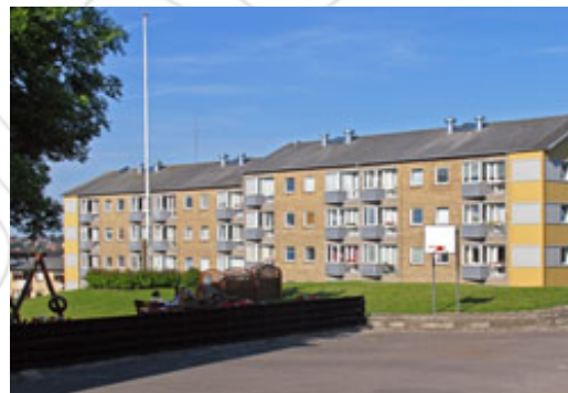
Etageboliger med store fælles friarealer.
